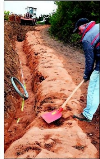
Nur mit schwerem Gerät ist der Graben durch den Fuchsmantel zu ziehen, in die das Starkstromkabel verlegt wird (linkes Bild: Walter Hensel auf dem Bock, Egon Schmitt). Eingebettet wird es in zwei Schichten Sand (rechts mit Schippe Helmut Christ). Nach zwei Arbeitstagen waren gestern 250 von gut 350 Metern zwischen „Kaffeemühlchen“ und Krähhöhlenweg geschafft.
