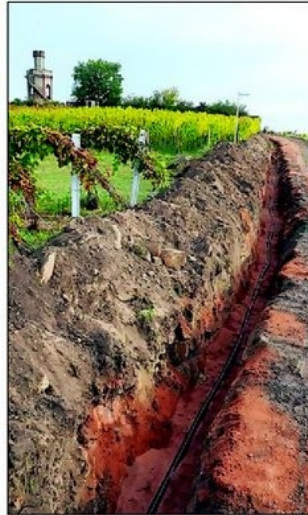
Nur mit schwerem Gerät ist der Graben durch den Fuchsmantel zu ziehen, in die das Starkstromkabel verlegt wird (linkes Bild: Walter Hensel auf dem Bock, Egon Schmitt). Eingebettet wird es in zwei Schichten Sand (rechts mit Schippe Helmut Christ). Nach zwei Arbeitstagen waren gestern 250 von gut 350 Metern zwischen „Kaffeemühlchen“ und Krähhöhlenweg geschafft.
