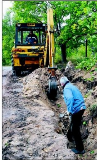
Nur mit schwerem Gerät ist der Graben durch den Fuchsmantel zu ziehen, in die das Starkstromkabel verlegt wird (linkes Bild: Walter Hensel auf dem Bock, Egon Schmitt). Eingebettet wird es in zwei Schichten Sand (rechts mit Schippe Helmut Christ). Nach zwei Arbeitstagen waren gestern 250 von gut 350 Metern zwischen „Kaffeemühlchen“ und Krähhöhlenweg geschafft.
