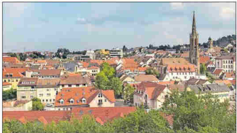
Traumhafte Aussicht: Der Vigilierturm liegt gerade richtig für einen reizvollen Blick auf die Stadt.
